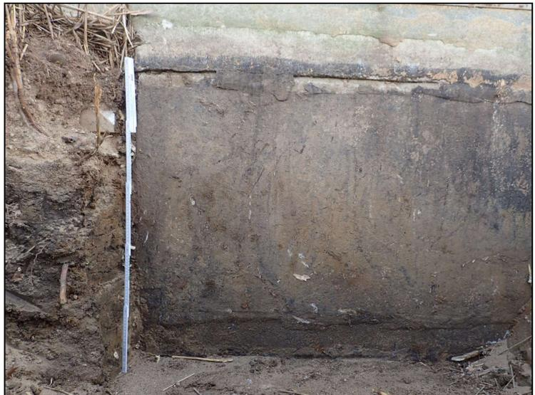
**Abb. 7: Fundamentbereich nach erfolgter Schürfe und Freilegung**
