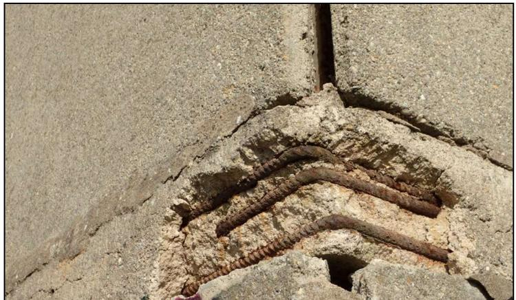
**Abb. 9: Problembereiche mit Fugen und Ringanker**
