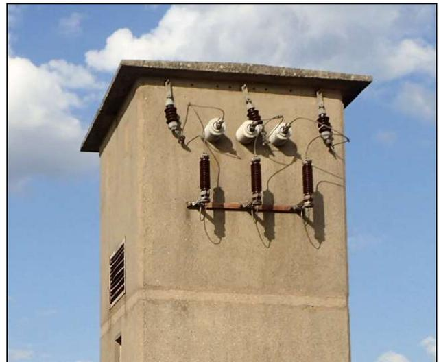
**Abb. 13: Oberteil mit Isolatoren und Dach**
